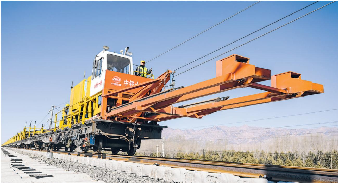
目前，包银高铁工程施工稳步推进，包银高铁内蒙古段铺轨任务完成过半。图为2月22日，施工人员在包银高铁内蒙古包头至临河区段进行铺轨作业。 新华社记者 连 振 摄
