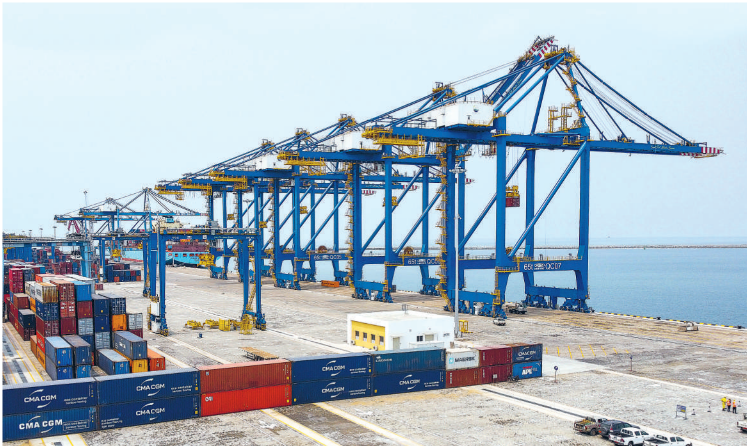
2月21日,由中国港湾工程有限责任公司(中国港湾)承建的喀麦隆克里比深水港二期工程完工仪式在克里比深水港码头举行。仪式上,克里比港务局与中国港湾签订完工证明书,标志着在经历5年多的建设后,该项目正式交付喀方。图为当天拍摄的克里比深水港。 新华社发
