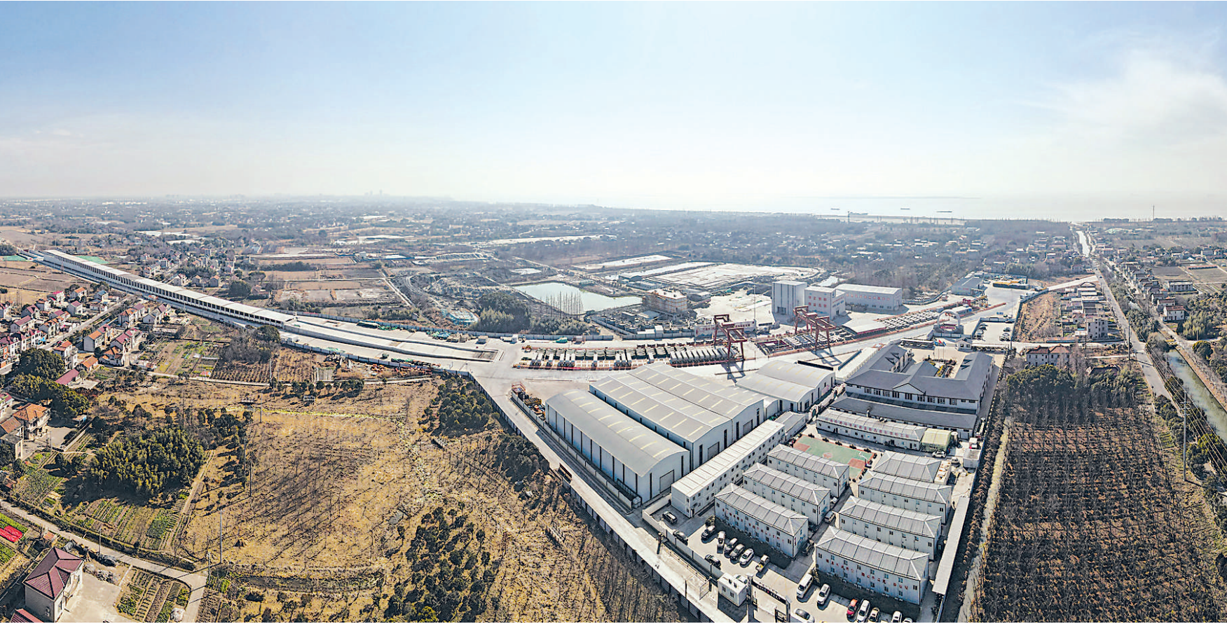
1月18日,我国自主研制、世界最大直径高铁盾构机——沪渝蓉高铁崇太长江隧道“领航号”掘进至第2000环,突破4000米大关,距离江心仅剩1600米。图为空中俯瞰沪渝蓉高铁崇太长江隧道盾构始发井施工现场。
