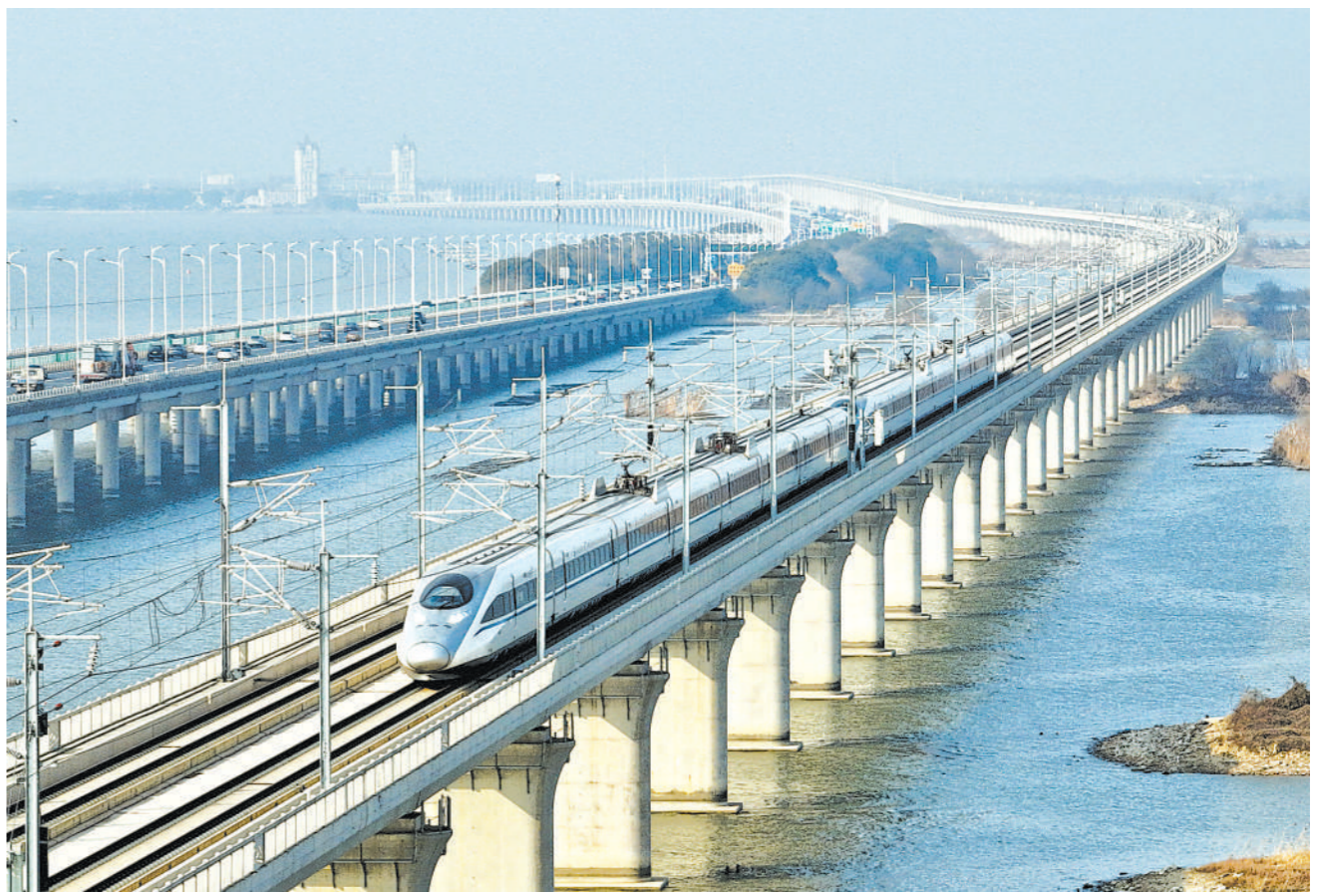
1月5日零时起,全国铁路实行新的列车运行图。图为1月4日,一列动车组列车驶过沪宁沿江高铁江苏常州溧湖特大桥段(无人机照片)。新华社
