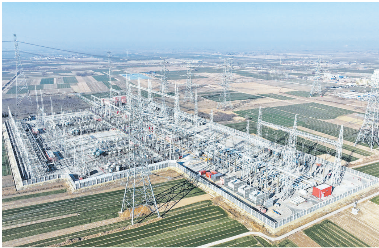
1月3日,位于河北省新河县境内的邢台1000千伏特高压变电站扩建工程竣工投运。据介绍,该变电站是京津冀鲁负荷中心的重要枢纽。扩建工程新增了2组300万千瓦安变变压器等设备,至此该站输电能力增至1200万千瓦安。图为当日拍摄的那台1000千伏特高压变电站(无人机照片)。
