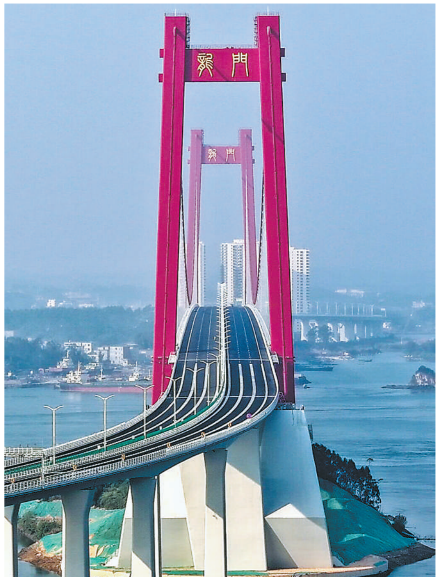
12月29日，位于广西钦州市的广西最长跨海大桥——龙门大桥顺利通车。龙门大桥项目路线全长7.637公里，采用双向六车道一级公路建设标准，设计行车速度每小时100公里。图为近日拍摄的龙门大桥（无人机照片）。
