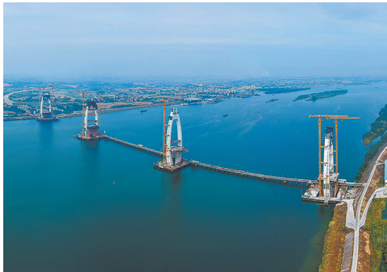
12月25日,清(清远清新)花(广州花都)高速公路北江特大桥首个主塔封顶。清花高速北江特大桥主桥全长1440米,为主跨360米的钻石型四塔双索面半漂浮体系斜拉桥。图为当日拍摄的清花高速北江特大桥封顶的主塔(右二)(无人机照片)。
