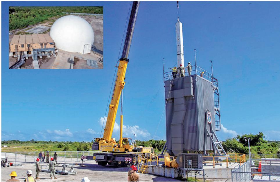
美军在Mk41发射系统中装填“标准-3”Block 2A拦截弹。左上小图:陆基“宙斯盾”系统配备的AN/TPY-6雷达。
