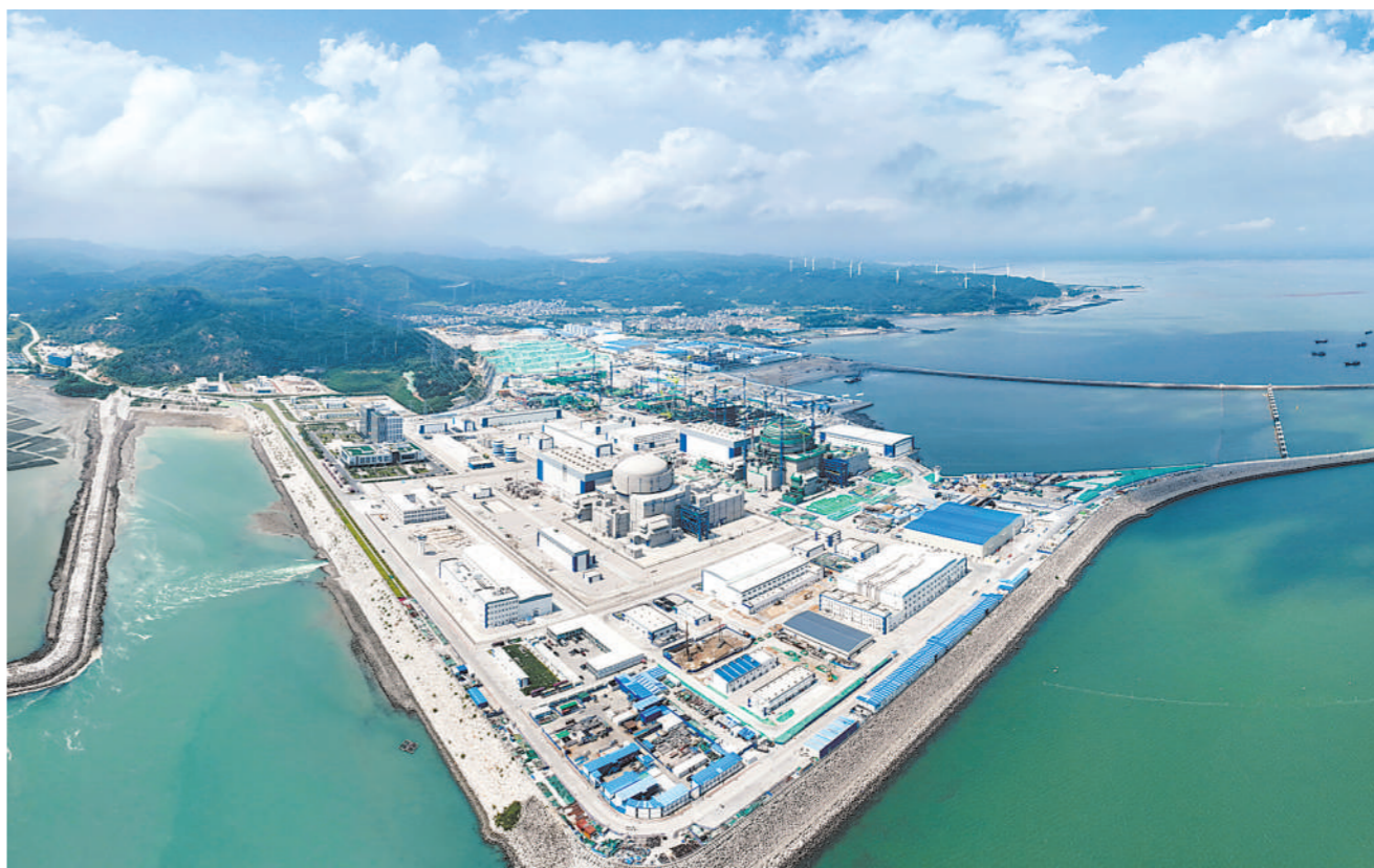
11月28日上午，我国具有完全自主知识产权的第三代核电技术——“华龙一号”漳州核电项目1号机组首次并网发电，开始向电网送电。图为建设中的漳州核电站。
