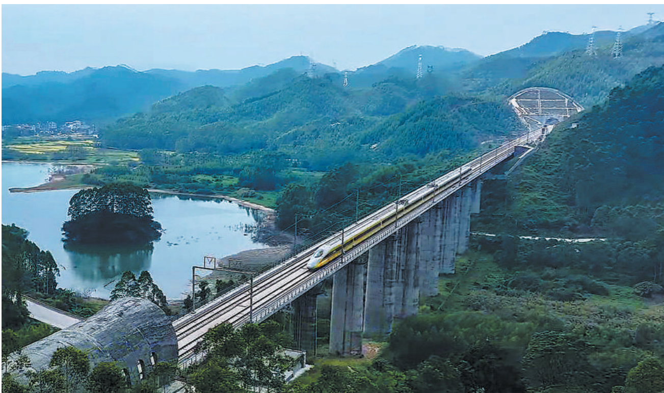
近段时间，中国铁路南宁局集团有限公司综合检测列车多次对南玉高铁进行联调联试，为年底开通做准备。图为综合检测列车在对南玉高铁进行联调联试。新华社记者 张爰林摄
