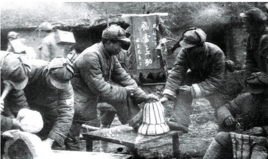
△陈列于淮海战役纪念馆的我军自制炸药发射筒（仿制品）。 △解放军用土布和电线捆扎飞雷炮的发射药。
