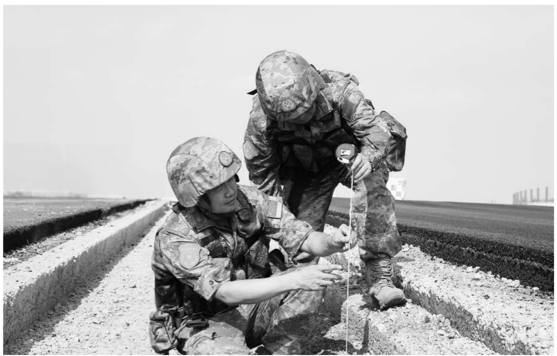
近日,武威军分区组织专业民兵分队道路抢修训练。图为负责监督检查的文职人员对分队道路抢修情况进行检查评估。姜峰摄
