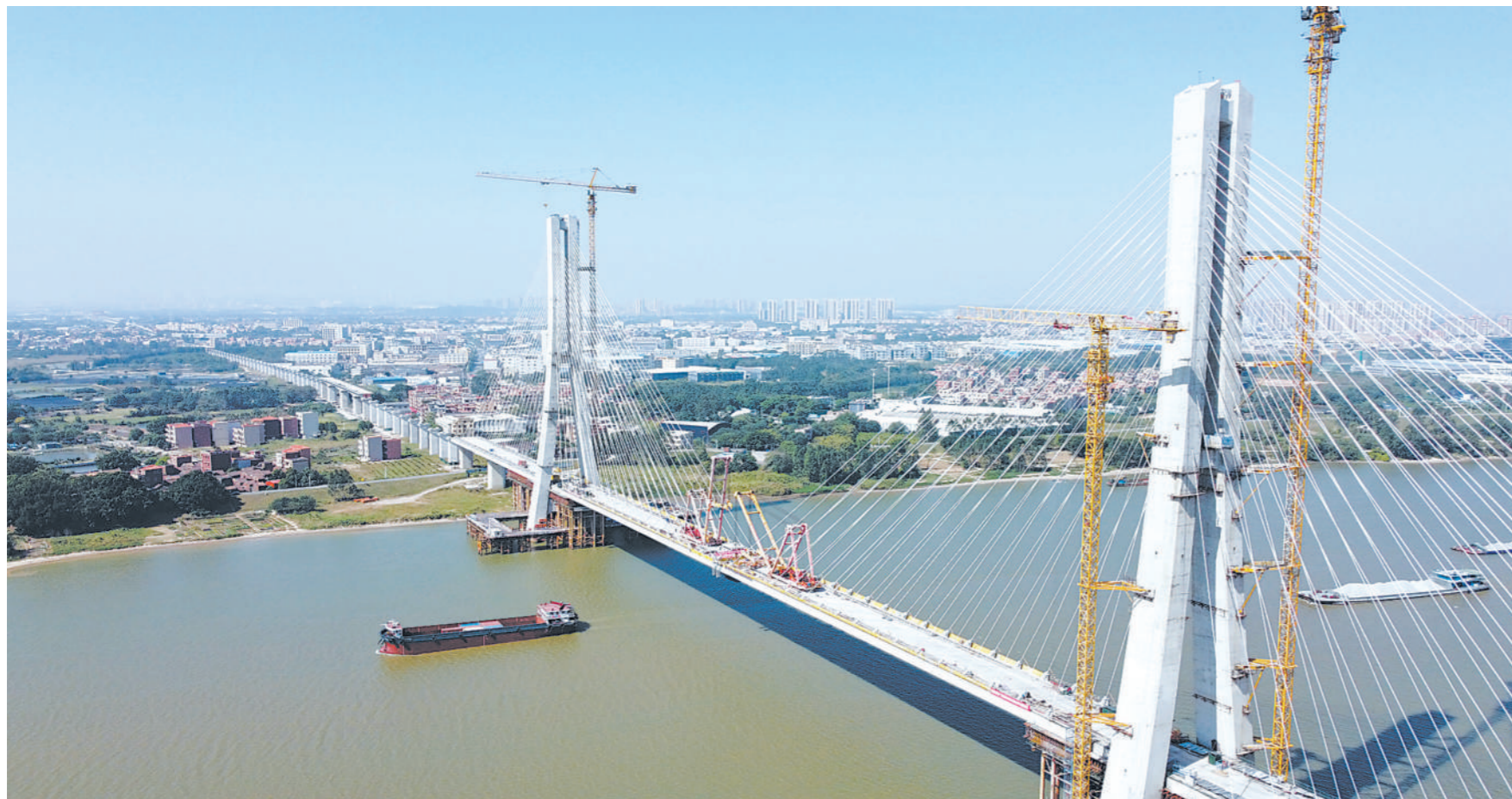
10月31日，广湛高铁佛山西特大桥跨东平水道斜拉桥顺利合龙，标志着大桥主体工程正式完工（无人机照片）。新华社记者 田建川摄
