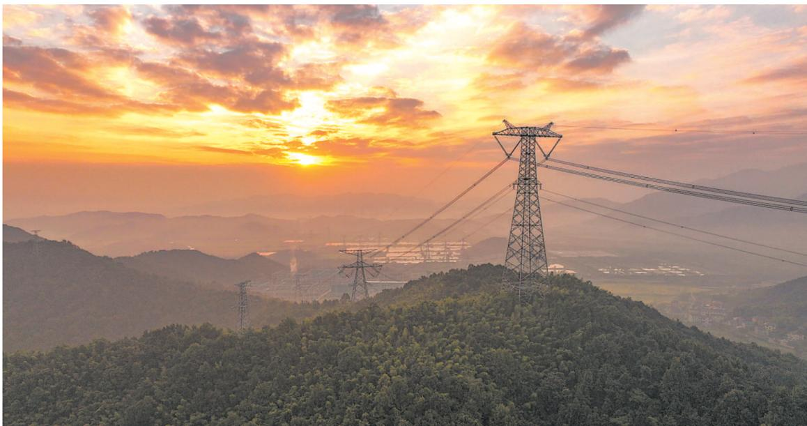
截至10月24日，“西电东送”特高压工程累计向浙江输电超7000亿千瓦时。图为当日拍摄的浙江省诸暨市次坞镇境内的宁夏灵州至浙江绍兴±800千伏特高压直流输电工程的输电线路（无人机照片）。
