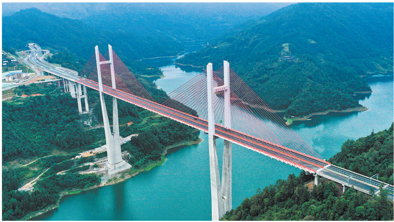
目前，贵州剑河至黎平高速公路各项建设已接近尾声，预计于今年内通车试运营。剑黎高速公路全长74.754公里，建成通车后，剑河县与黎平县之间车程将缩短至1小时左右，对构建黔东南黄金旅游通道、加快沿线资源综合开发、助力乡村振兴具有重要意义。图为10月20日拍摄的剑黎高速南孟溪大桥(无人机照片)。 新华社记者 杨文斌摄
