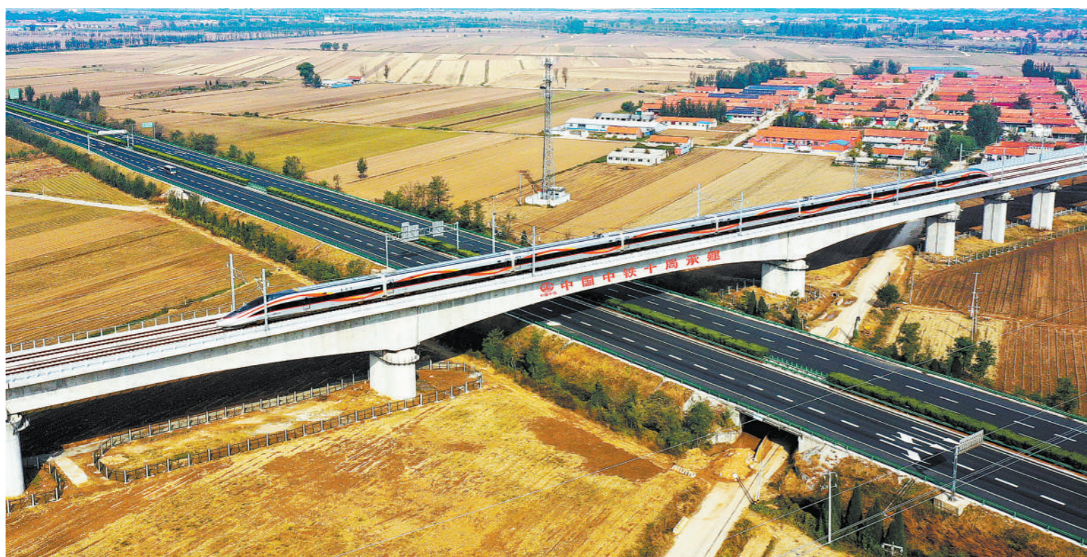
10月21日，新建潍坊至烟台高铁开通运营，山东高铁通车里程达3047公里。潍烟高铁是我国“八纵八横”高铁网沿海高铁通道的重要组成部分和山东省北部沿海地区对外客交流的主要通道。图为当日一列复兴号列车驶过潍烟高铁昌平特大桥。
