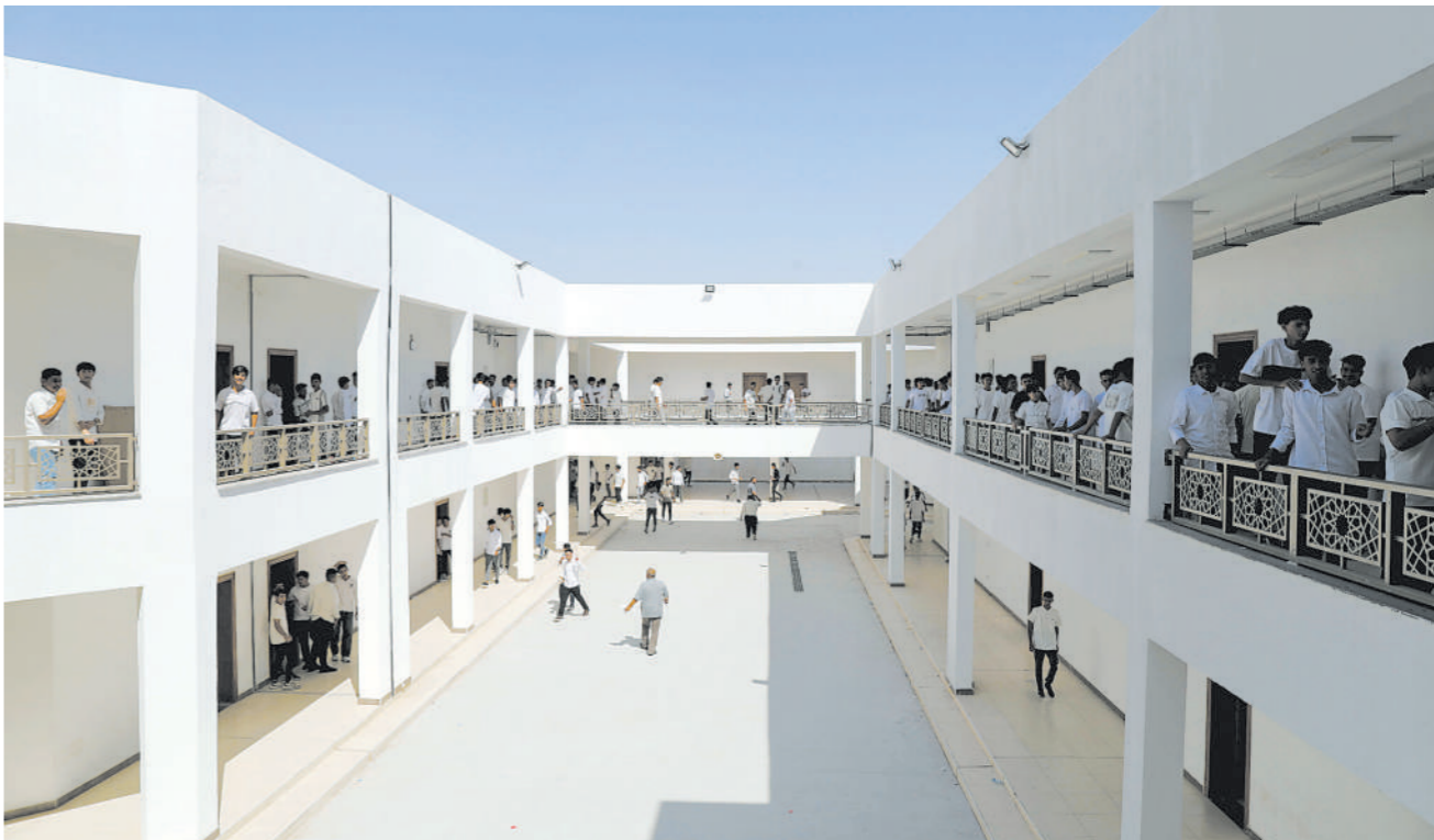
在伊拉克,连年战乱冲突严重破坏了当地教育体系和教育基础设施。中国电建湖北工程有限公司负责伊拉克穆萨纳省53所学校的施工建设,目前已实现整体完工,完全交付后可为超过5万名当地学生提供学习场所。这是日前在伊拉克穆萨纳省拍摄的一所中企承建示范学校。
