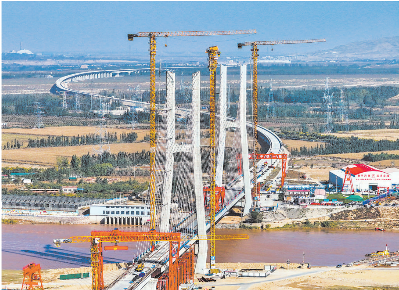
10月9日,包银高铁乌海黄河特大桥顺利合龙贯通,为线路早日建成通车迈出坚实一步。包银高铁是我国“八纵八横”高速铁路网京兰通道的重要组成部分,设计时速250公里,是西北地区连接东北、华北地区的交通大动脉和经济大通道。
