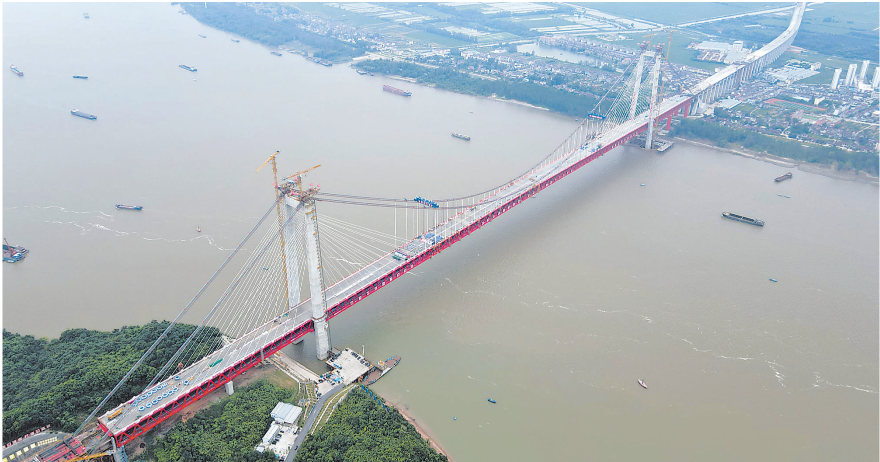
8月27日,G3(京台高速)铜陵长江公铁大桥主桥合龙。该桥全长11.88公里,主跨988米,具有高速公路、城际铁路、货运铁路三种过江功能。图为当日拍摄的铜陵长江公铁大桥合龙现场(无人机照片)。新华社记者 刘军喜摄
