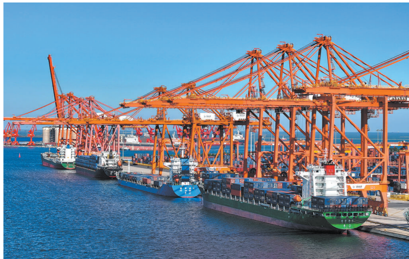
今年1至7月份河北唐山港完成货物吞吐量4994.2万吨,同比增长2.96%,呈现稳中向好的发展态势。图为8月27日,轮船靠泊在唐山港京唐港区集装箱码头作业(无人机照片)。
