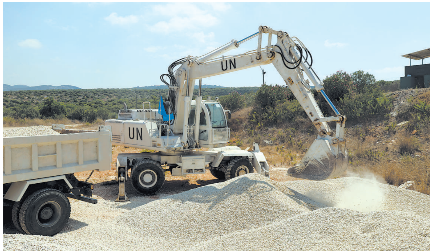
近日，中国第22批赴黎巴嫩维和建筑工程分队多点同步开展为黎黎司令部构筑防御工事任务，高效的施工得到有关部门好评。图为分队官兵在转运工程材料。
