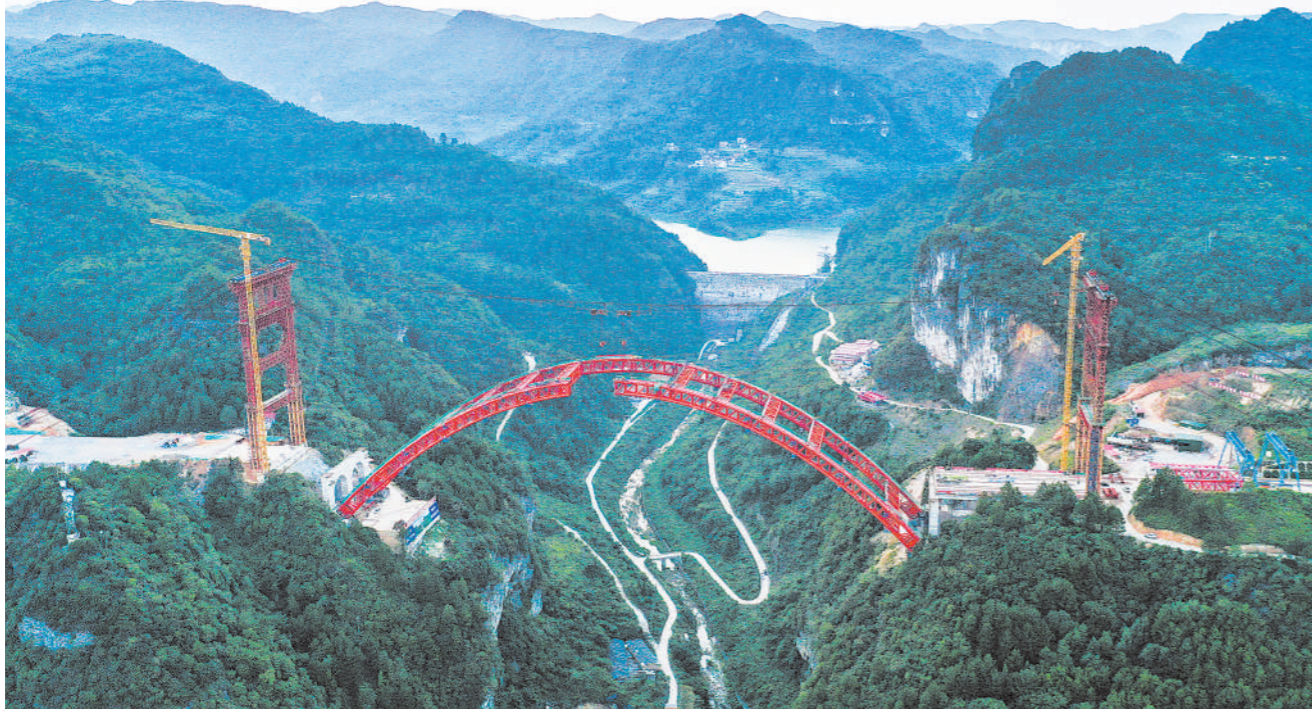
8月21日,贵阳至平塘高速公路马场河特大拱桥主拱顺利合龙。马场河特大拱桥全长381.5米、主跨260米。这是8月20日拍摄的马场河特大拱桥施工现场(无人机照片)。
