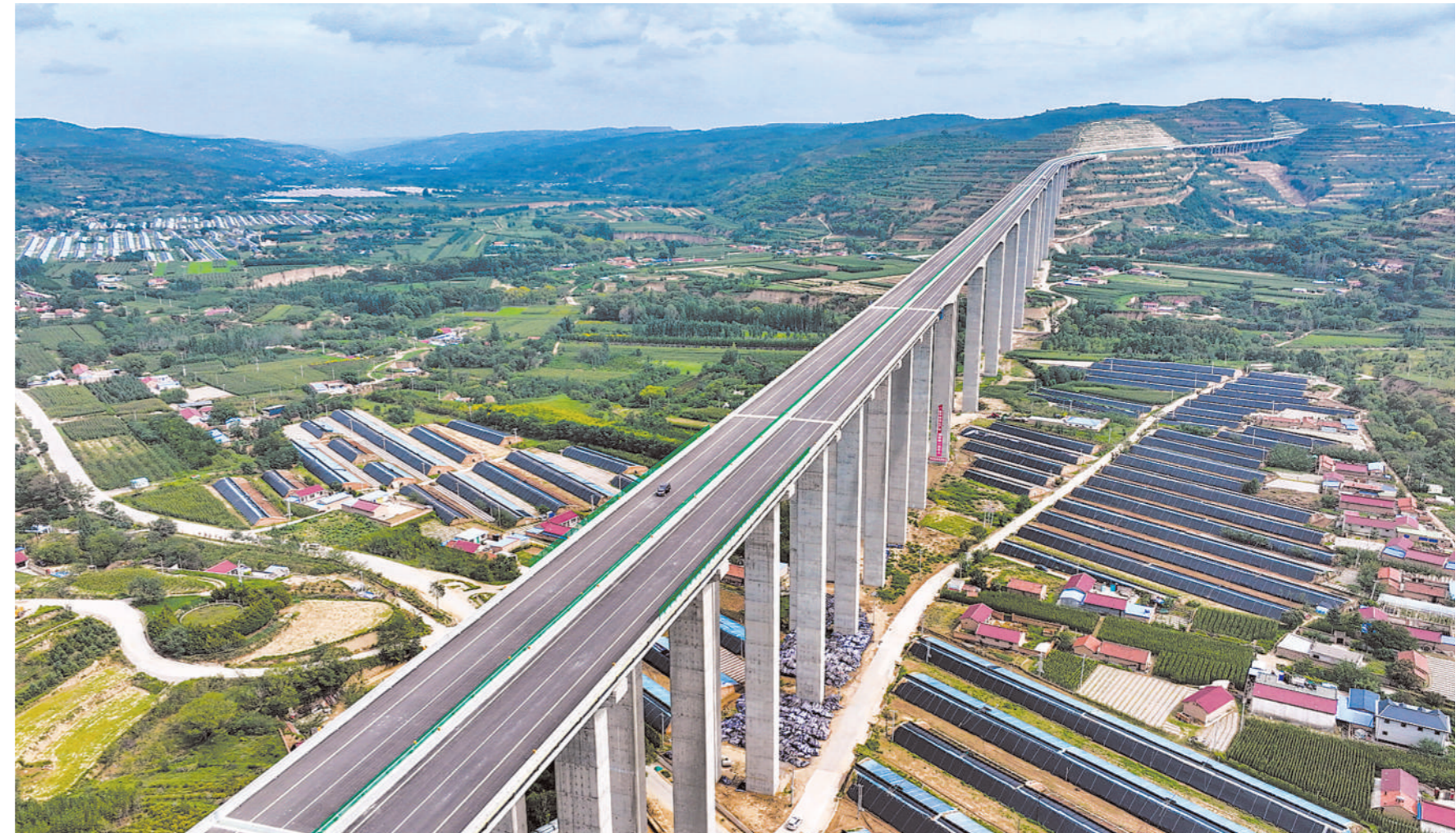
8月16日,银川至昆明高速公路(G85)宁夏境太阳山开发区至彭阳段建成通车,标志着银昆高速全线贯通。图为车辆行驶在银昆高速友谊红河特大桥上(无人机照片)。
