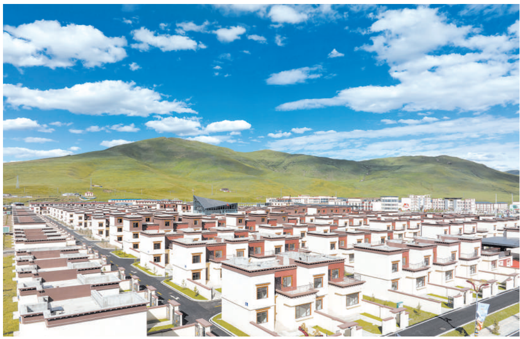
8月10日,四川甘孜藏族自治州色达县色柯镇约若新村举行了交房仪式,240户牧民将变成城镇居民。曾经的约若村因年代久远,呈现出老、旧、破的现状。当地政府于2022年启动乡村振兴示范项目建设,整合资金在色达县城郊建设住房240套,并在改造和提升新村设施的基础上,打造民宿产业和非遗展示中心,让这里成为全县棚户区改造及乡村振兴的特色示范新村。图为当日拍摄的色达县色柯镇约若新村(无人机照片)。
