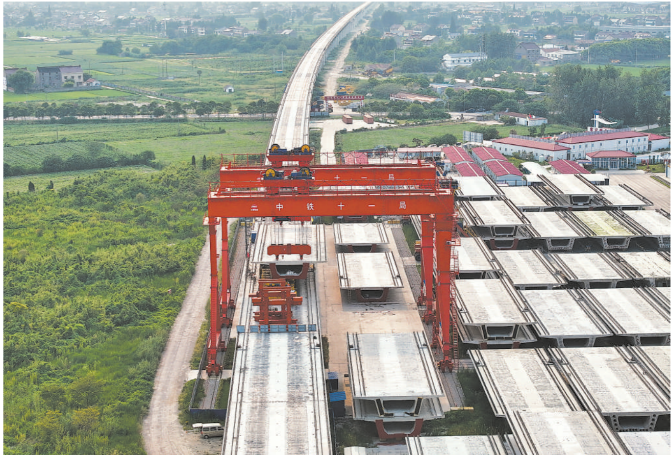
8月9日,提梁机在沪渝蓉高铁沪宁段站前IX标施工现场作业。
