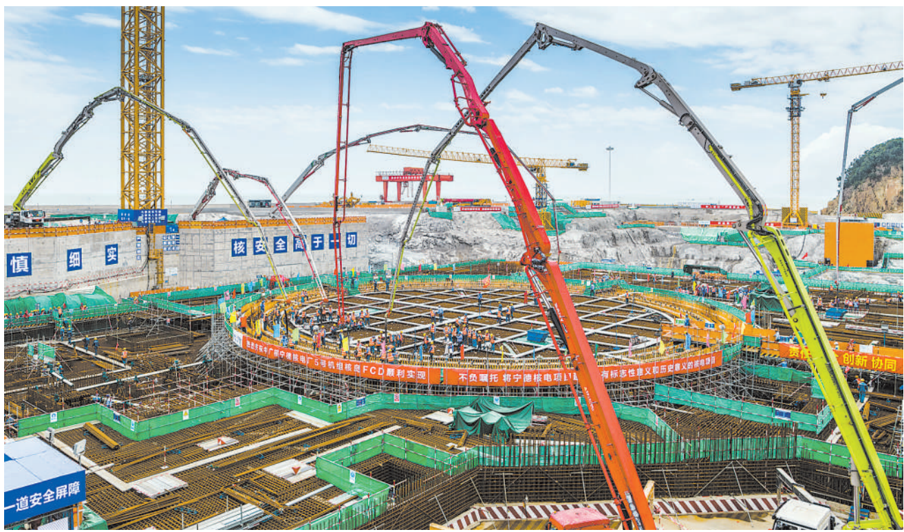
7月28日,中广核福建宁德核电站5号机组核岛浇筑第一罐混凝土,标志着这个机组主体工程正式开工,宁德核电项目二期工程建设序幕由此拉开。图为开工现场(无人机照片)。新华社发
