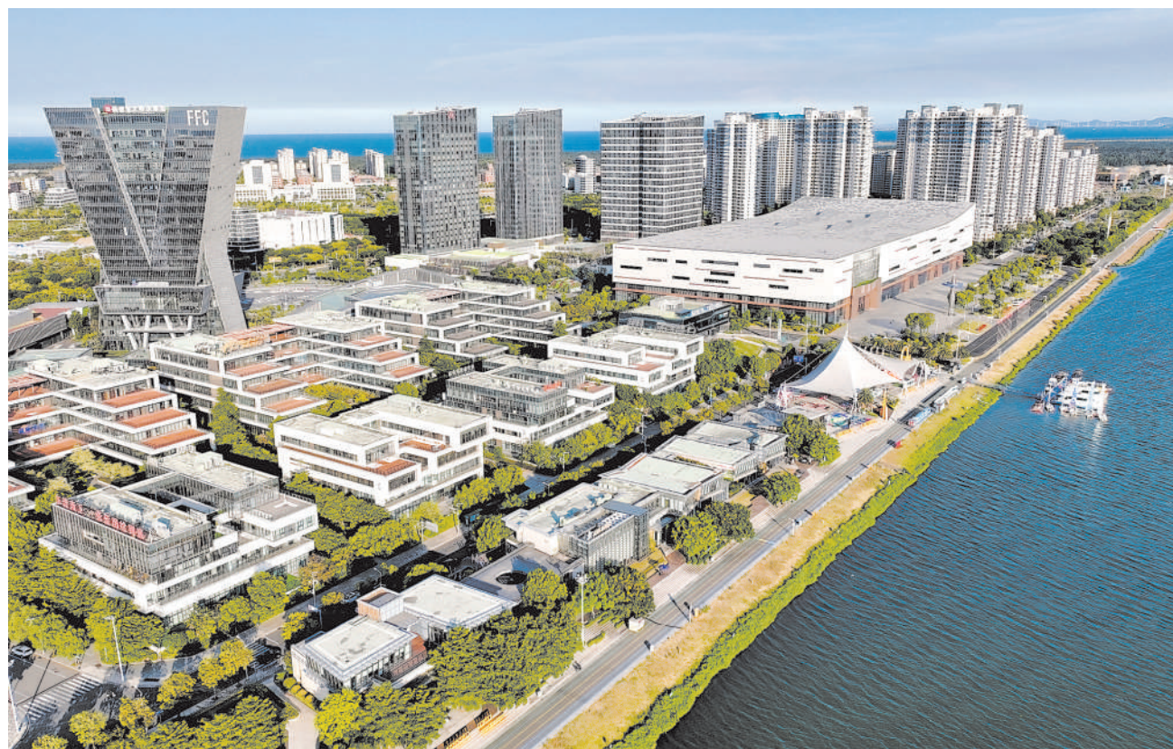
福建省福州新区围绕“数字产业化、产业数字化”目标，深入推进数字经济创新发展，推动5G、人工智能大模型、大数据、云计算等新一代信息技术深度应用，通过人才引进、科技创新、强化金融服务和落实财税等惠企政策，加快打造东南沿海重要现代产业基地。图为7月17日拍摄的福州新区滨海新城核心区一角（无人机照片）。
