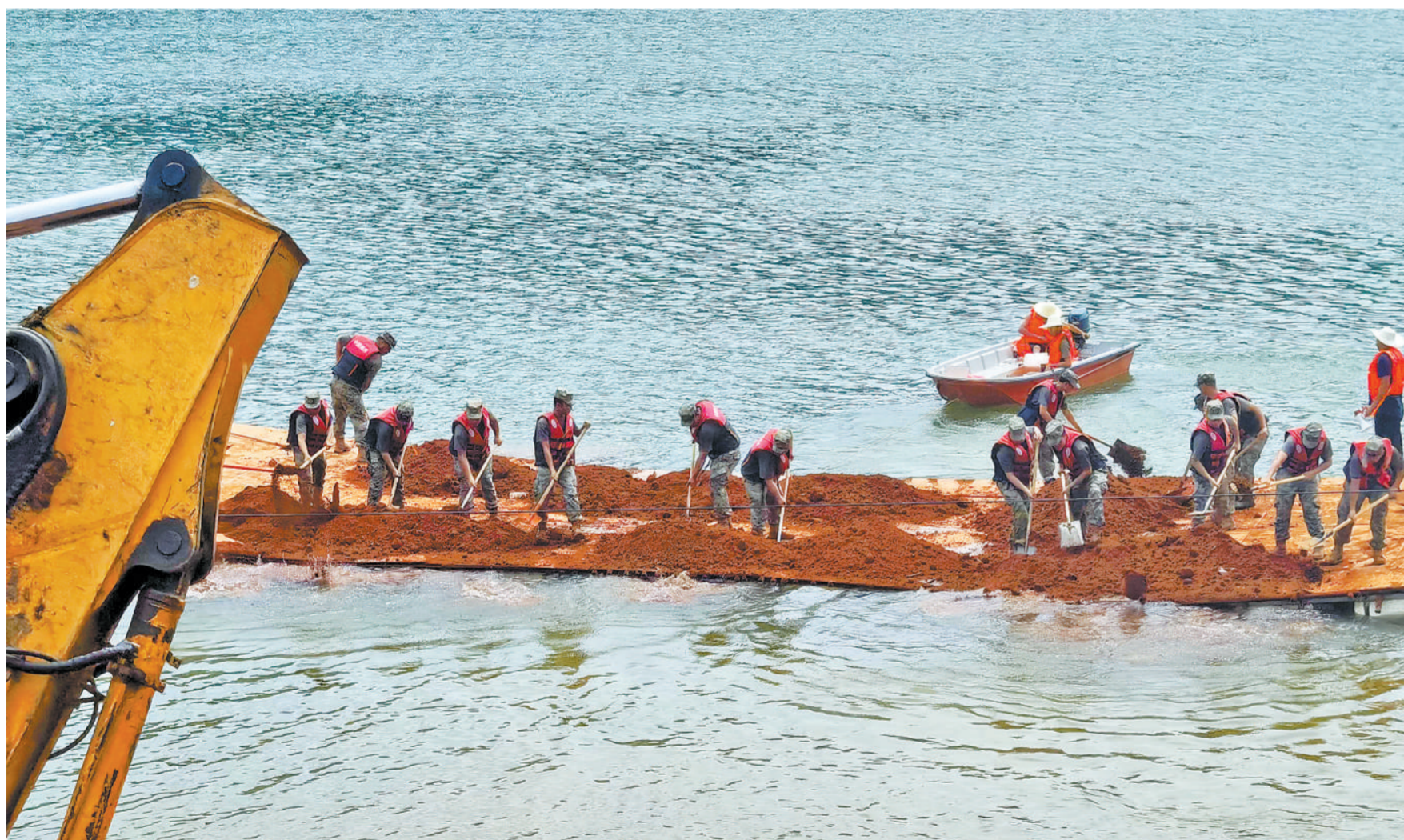
7月9日，湖南省平江县九峰水库突发险情，平江县民兵应急连和乡镇应急排110人紧急赶赴现场除险。图为民兵在内坡浮台抛撒黏土加固堤防。 郭兴义摄
