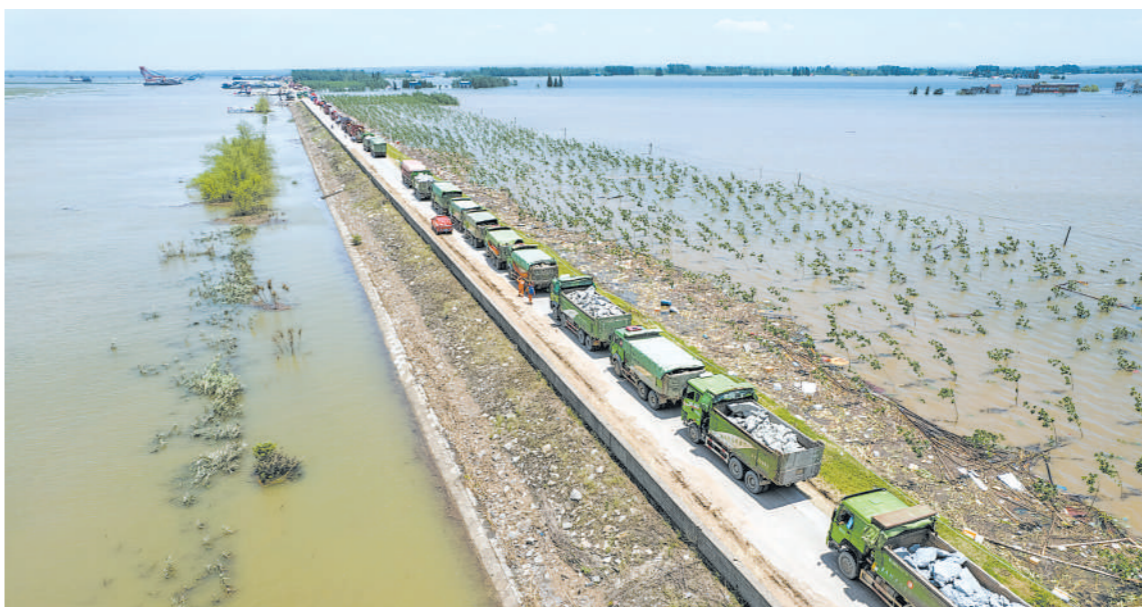
七月七日，在湖南岳阳市华容县团洲垸洞庭湖决口现场，抢险车队排队进行堵口作业。新华社记者 陈思汗摄
