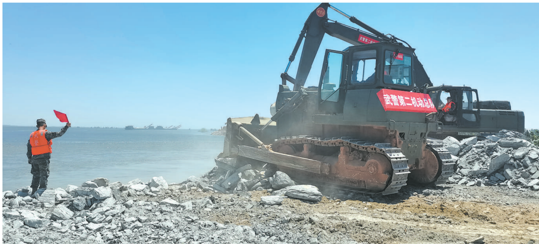
7月7日，湖南省岳阳市华容县团洲垸洞庭湖决堤封堵现场，武警第二机动总队某支队官兵操作机械进行决口封堵作业。
