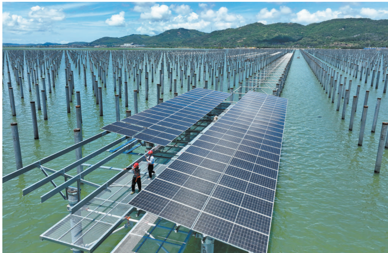
三峡集团东山西杏180MW海上光伏电站采用上部光伏发电与下部海域渔业养殖相结合的模式,实现海域立体综合开发。图为6月20日,施工人员在海上光伏电站现场安装支架和光伏组件(无人机照片)。新华社记者林善摄
