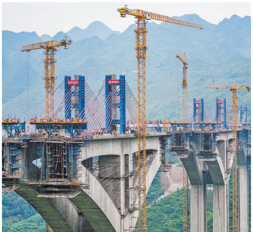
6月17日，随着六枝特大桥8.9号主墩空腹区交汇，纳纳（纳雍至晴隆）高速六枝特大桥全桥上下弦全部完成“交会对接”，即将转入“刚构桥”施工阶段，大桥建设取得了阶段性胜利。图为建设中的六枝特大桥。 新华社记者 陶亮摄
