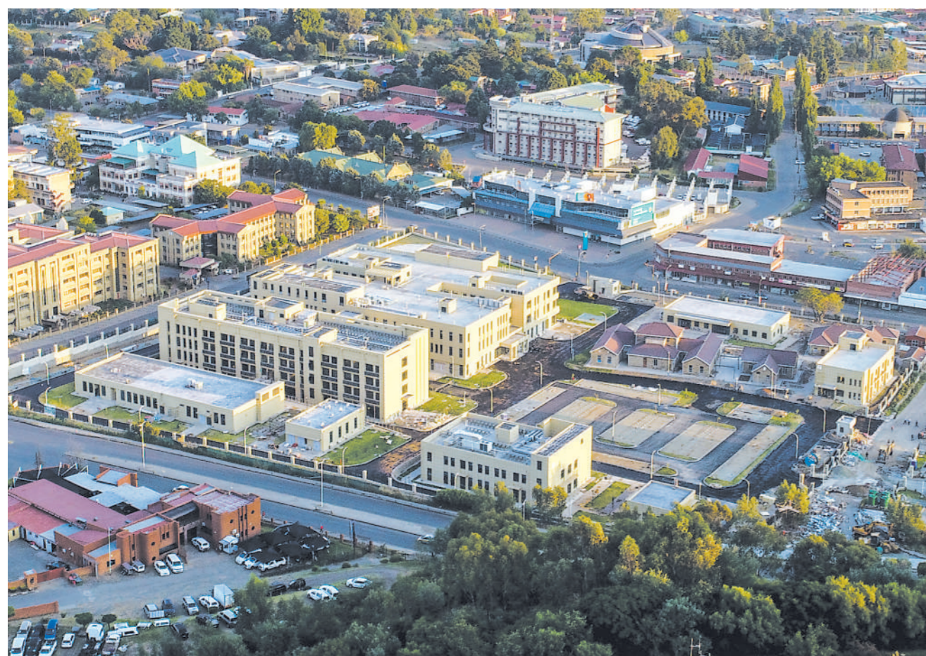
6月13日，中国援建莱索托马塞卢地区医院和眼科诊所项目竣工交接仪式在莱索托首都马塞卢举行。图为在马塞卢拍摄的中国援建莱索托马塞卢地区医院和眼科诊所项目。
