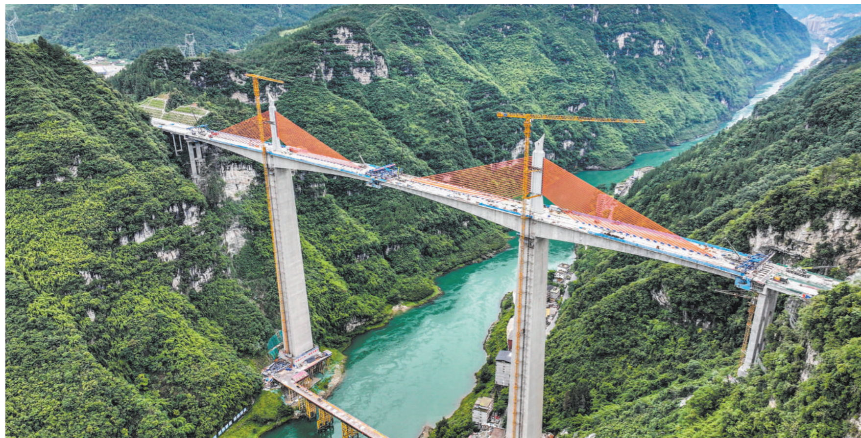
近日,位于重庆市彭水苗族土家族自治县境内的渝湘复线高速磨寨乌江特大桥进入最后一节2米连续梁浇筑施工作业,该桥即将实现全桥合龙。图为6月9日拍摄的磨寨乌江特大桥建设现场(无人机照片)。新华社记者 唐奕摄
