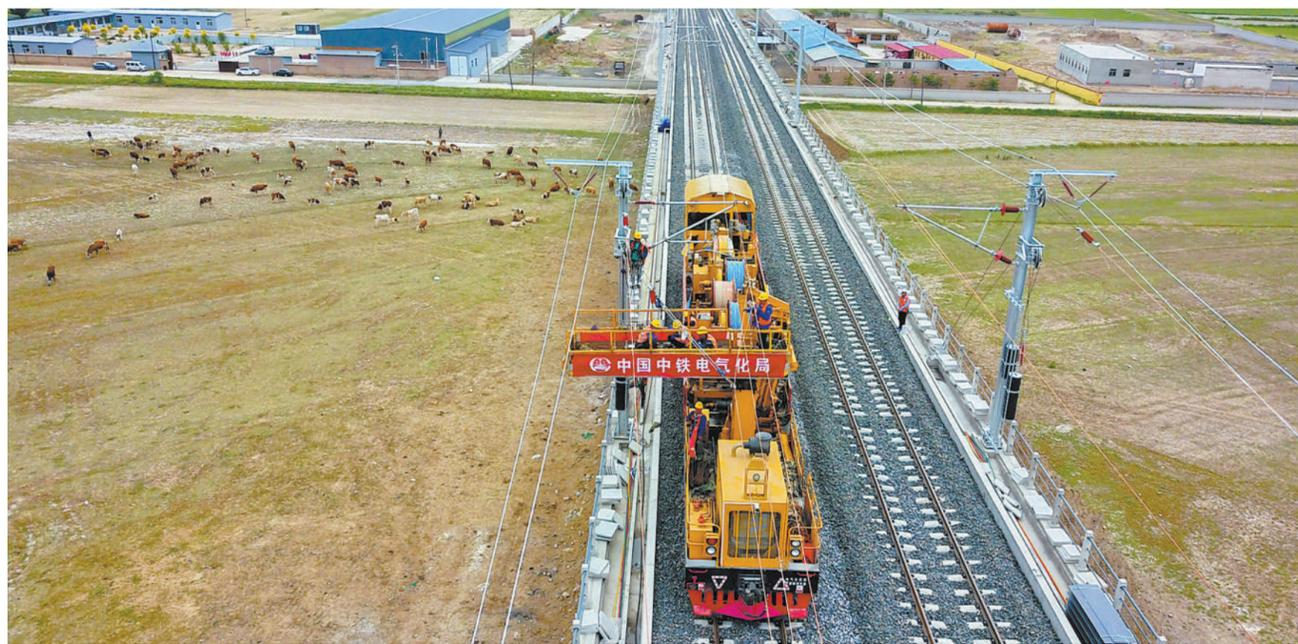
6月3日，集宁经大同至原平高速铁路(集大原高铁)首批接触网成功架设，标志着集大原高速铁路四电工程施工进入冲刺阶段。集大原高铁是我国“八纵八横”高速铁路网呼南通道的重要组成部分，预计2024年底具备通车条件。图为当日，工人在集大原高铁山阴南至应县西区间作业(无人机照片)。
