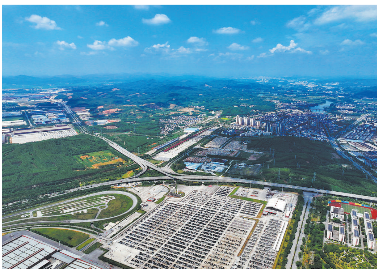
近年来,广西积极构建“粤港澳大湾区研发+广西制造+东盟市场”产业协作体系取得明显成效。图为位于广西柳州市柳东新区的上汽通用五菱汽车股份有限公司宝骏基地(无人机照片,5月24日摄)。新华社记者 黄孝邦 摄
