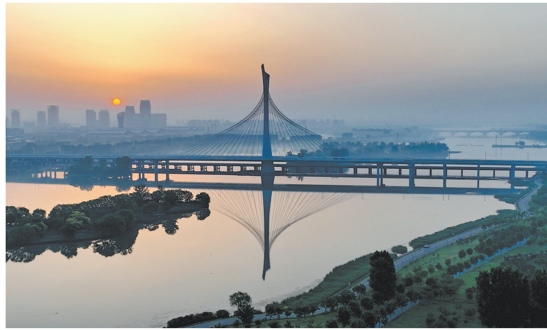
近年来，河北省石家庄市积极推动城市路网交通体系建设，通过打造完成复兴大街和北三环市政化改造等项目，进一步拉开城市发展框架，形成外通内畅、转换高效、区间融合的城市路网新格局，有效提升了城市道路通行能力和城市形象。图为5月14日拍摄的石家庄市复兴大街滦沱河特大桥。新华社记者 杨世尧摄
