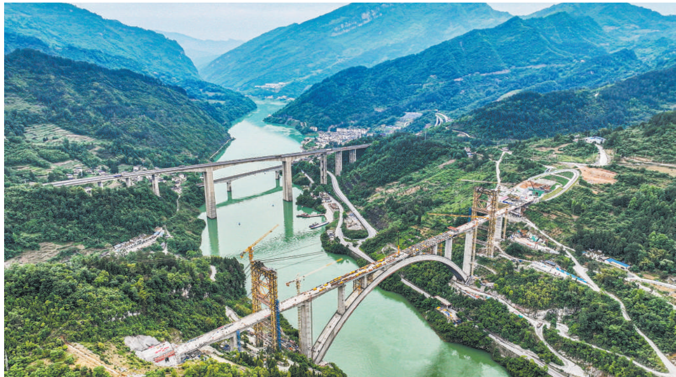
近日，由中铁大桥局承建的渝湘高铁重庆至黔江段黄草乌江双线大桥顺利实现合龙，进入桥面系及附属工程施工阶段。图为5月6日拍摄的正在建设的渝湘高铁黄草乌江双线大桥（无人机照片）。
