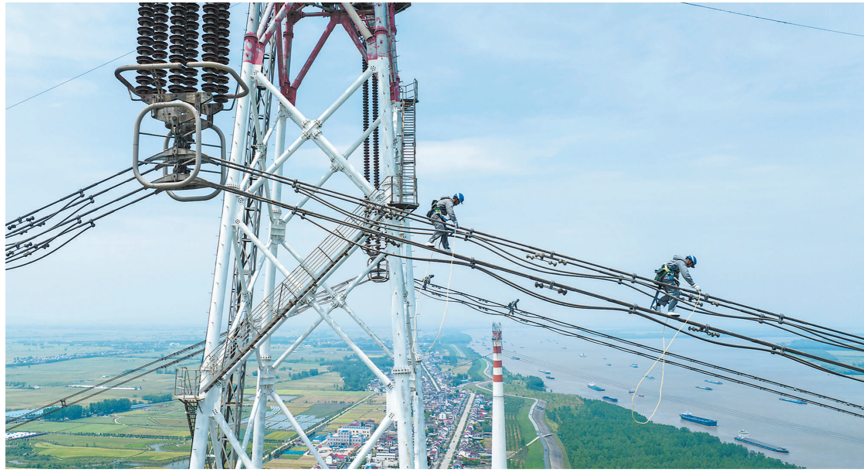
5月1日，在安徽省安庆市望江县，安徽送变电工程有限公司检修工人在200多米高空检修±800千伏特高压锦苏线跨长江线路（无人机照片）。
