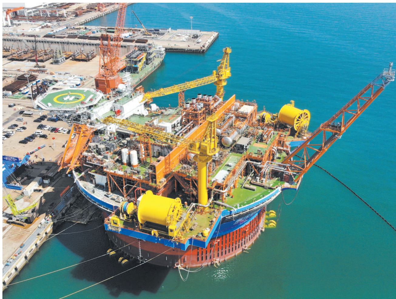
亚洲首艘圆筒型浮式生产储卸油装置建造完工
