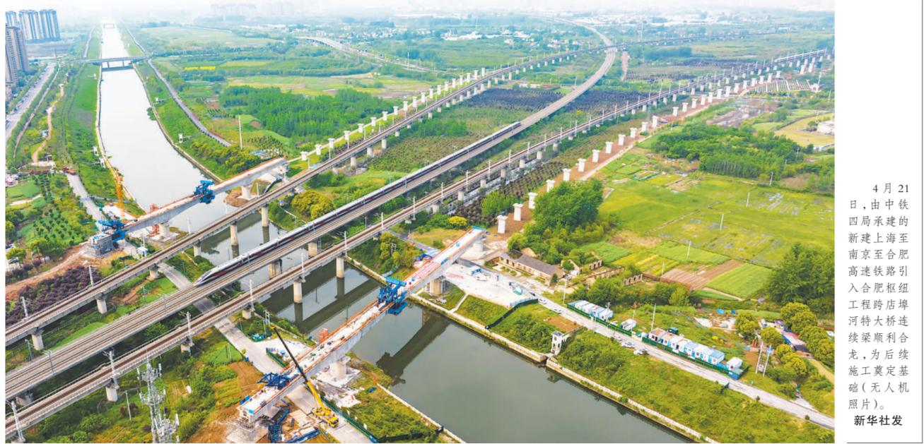
4月21日，由中铁四局承建的新建上海至合肥高速铁路引入合肥枢纽工程跨店埠河特大桥梁连续梁顺利合龙，为后续施工奠定基础(无人机照片)。新华社发
