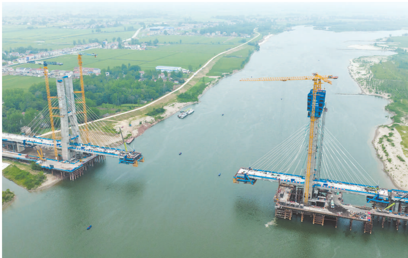
4月16日,沪渝蓉高铁武宜段钟祥汉江特大桥316号主塔顺利封顶。沪渝蓉高铁是我国“八纵八横”高铁网沿江高铁通道的重要组成部分,其中,武汉至宜昌段正线全长313公里。钟祥汉江特大桥横跨汉江,是沪渝蓉高铁武宜段的关键控制性工程。图为当日拍摄的钟祥汉江特大桥316号主塔施工现场(无人机照片)。新华社记者 杜子璇摄
