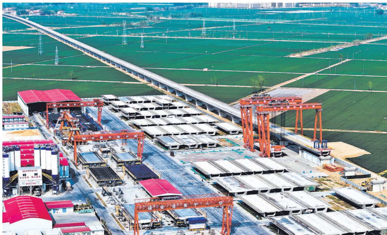
国家重点工程雄(安)商(丘)高铁山东菏泽项目正有序推进。雄商高铁是我国高速铁路网“八纵八横”之京港(台)通道的重要组成部分,正线全长552公里,设计时速350公里。图为4月12日在雄商高铁山东菏泽段中铁十局双桥梁场,箱梁整齐码放(无人机照片)。
