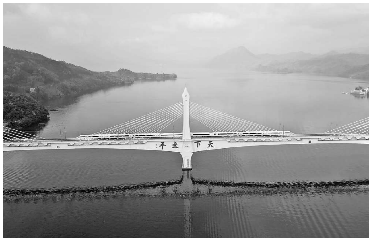
3月26日，池黄高铁开始试运行。池黄高铁起自安徽池州站，终至安徽黄山黟县东站，是武（汉）杭（州）快速铁路通道的重要组成部分。新华社发
