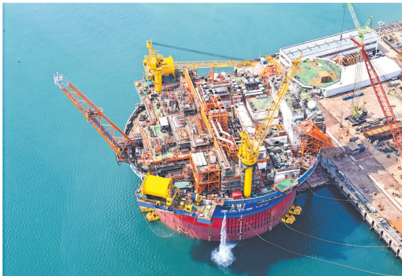
4月7日,由我国自主设计建造的亚洲首艘圆筒型“海上油气加工厂”——“海洋石油122”浮式生产储卸油装置(FPSO),在青岛工程船坞进行海上倾斜试验及调试,为项目年内投产奠定基础。“海洋石油122”被称为“超级能源碗”,最大排水量10万吨,最大储油量6万吨,可连续在海上运行15年不回坞。图为当日,该装置进行海上倾斜试验及调试(无人机照片)。
