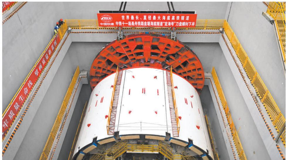
4月5日,甬舟铁路金塘海底隧道舟山侧“定海号”盾构机核心部件组装完成,为甬舟铁路金塘海底隧道盾构机始发穿海奠定基础。图为当日拍摄的“定海号”盾构机刀盘被履带式起重机从地面吊运至甬舟铁路金塘海底隧道舟山侧盾构始发井。
