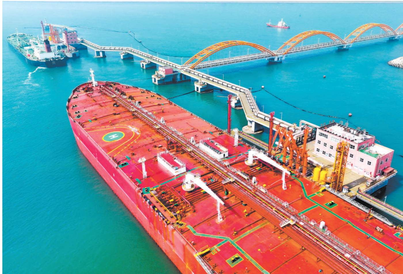
近年来，山东港口日照港充分发挥联动陆海、东西互助、衔接南北区位优势，着力打造北方能源枢纽港，目前已建成4座30万吨级原油码头。2024年1月至2月，日照港油品业务完成吞吐量1403万吨，同比增长7.5%。图为3月29日，在山东港口日照港岚山港区30万吨级油品码头，船舶停靠进行卸油作业（无人机照片）。 新华社记者 郭绪雷摄
