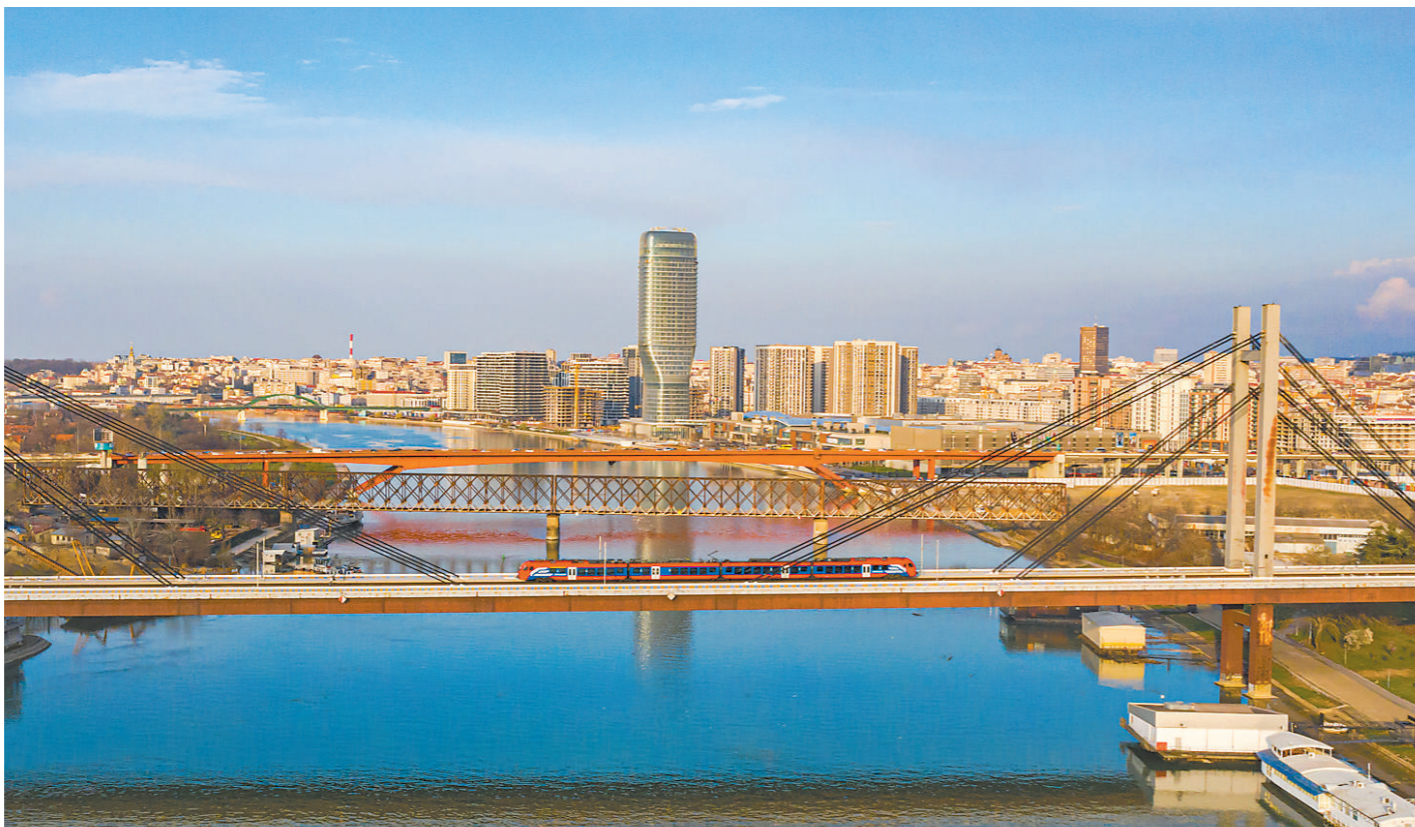
3月19日，中国与中东欧国家共建“一带一路”重点项目匈塞铁路塞尔维亚境内贝诺段（贝尔格莱德至诺维萨德）安全平稳运营满两周年，累计发送旅客超683万人次。诺苏段（诺维萨德至苏博蒂察至匈塞两国边境）工程建设加快推进，将于年底前具备开通运营条件。图为近日一列客车运行在匈塞铁路塞尔维亚境内贝诺段的贝尔格莱德萨瓦河大桥上。
