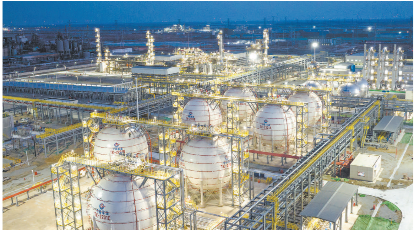
3月18日，渤海油田最大天然气处理厂——位于山东的滨州天然气处理厂正式向环渤海地区供气，我国北方海上油气资源外输和保供能力取得新突破。图为滨州天然气处理厂一角（无人机照片）。 新华社发
