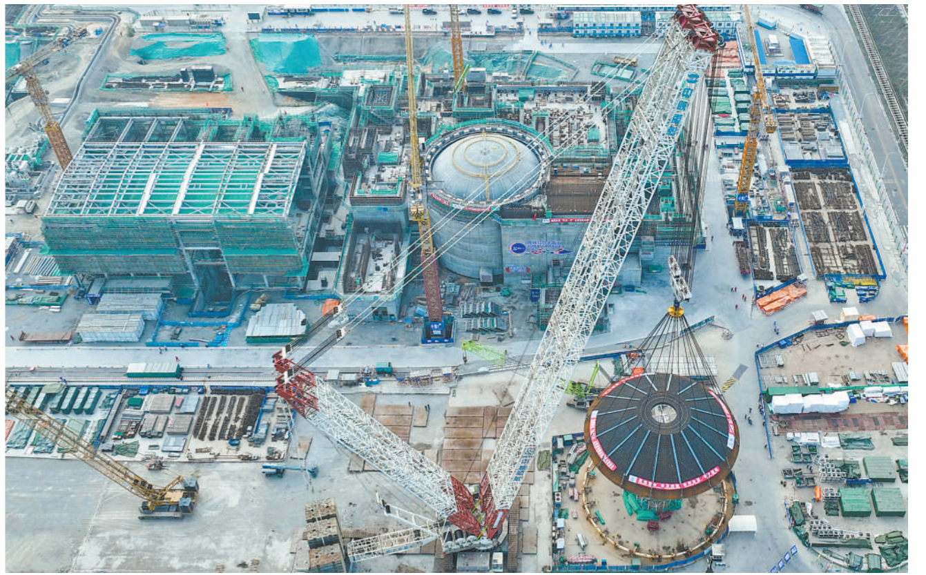
2月6日，海南昌江核电厂多用途模块化小型堆科技示范工程“玲龙一号”外穹顶吊装完成。据了解，“玲龙一号”是全球首个开工建设的陆上商用多用途模块化小型压水堆，是中核集团继“华龙一号”后我国核电自主创新又一重大成果。图为当日，“玲龙一号”外穹顶在进行吊装作业(无人机照片)。
